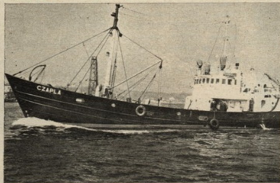
Oryginalną nazwę CZAPLA oraz mało zmienioną sylwetkę zachował statek ratowniczo-rozpoznawczy Polskiego Ratownictwa Okrętowego, przebudowany z seryjnego lugrotrowlera w 1959 r. Wyposażony jest m. in. w echosonde poziomą i aparaturę telewizyjną do poszukiwania wraków. (fot. J. Ukłejewski)
